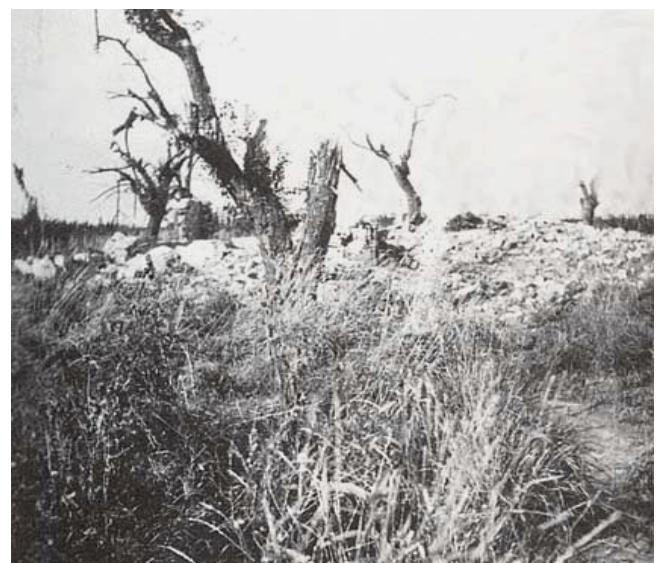
1945. De boom na de gevechten
